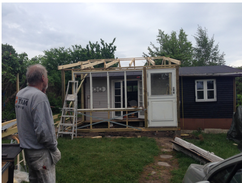
Hér bygger Nordbakken 53 - det bliver flot.
